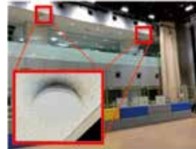
傾斜路走行試験装置エリア
